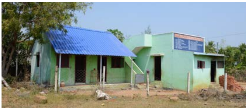
Neues Dach des Gästehauses in Pulikkundram
